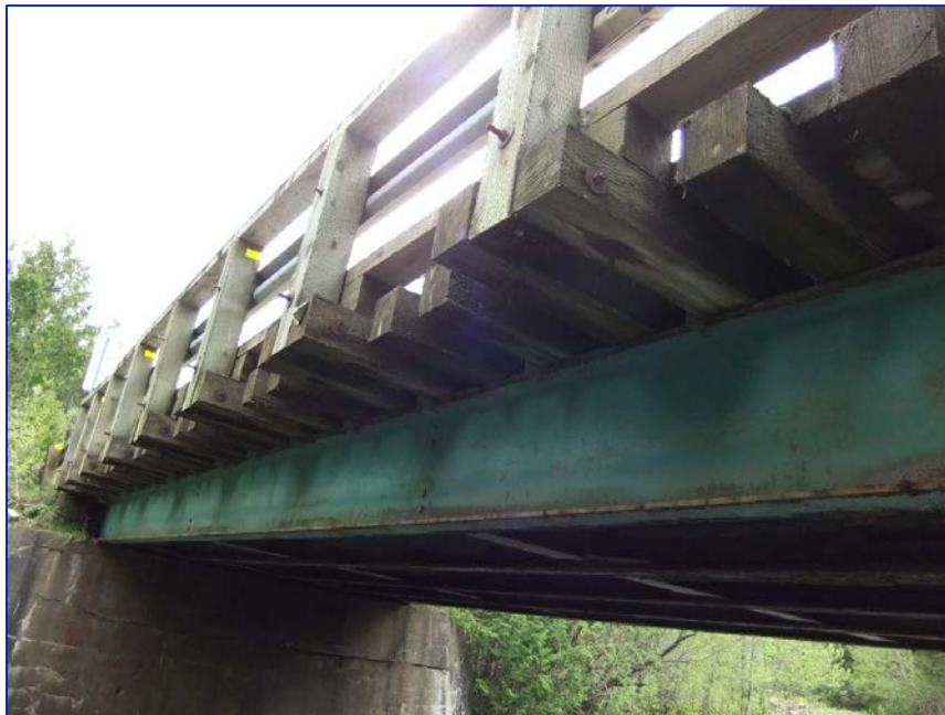
Photo 2.4-1 Vue des traverses de bois
