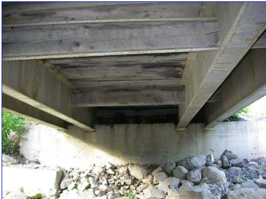
Photo 2.3-3 Autre système de contreventements
