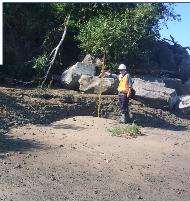
Érosion dans la zone adjacente gauche à l'extrémité d'un enrochement (l'érosion affecte le talus derrière l'ouvrage)
